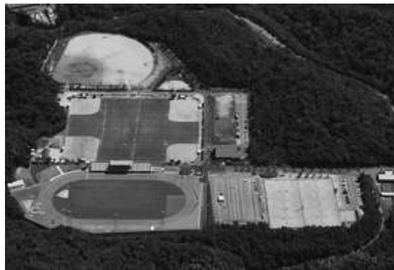
呉市総合スポーツセンター
